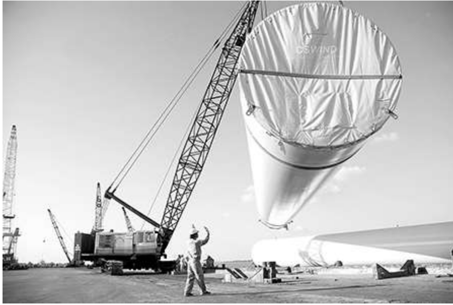
Bốc xếp trang thiết bị phục vụ đầu tư xây dựng Dự án Điện gió Bạc Liêu tại Cảng Cái Cui. Ảnh: CTV
